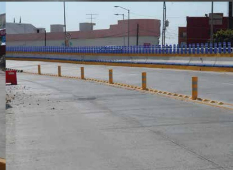
El Viaducto Elevado cuenta con una longitud de 1 km y con un ancho de calzada de 15.40 m.
