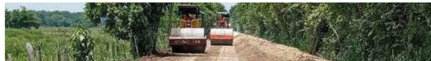
Construcción de Macropera Madrefil 41 de 120 m x 125 m y camino de acceso de 7 m de ancho y 1 km de longitud. 70,000 m<sup>2</sup> de Terracerías. Cunduacán, Tabasco.
