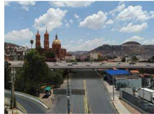
Construcción de un viaducto elevado de 3.34 km de longitud, 16 m de ancho, 2 carriles de circulación por dentado con una estructura que incluye 65 claros, 46 apotos intermedios, 18 apoyos tipo pórtico, 2 estribos y 231 m de rampas de acceso con muro mecánicamente estabilizado
