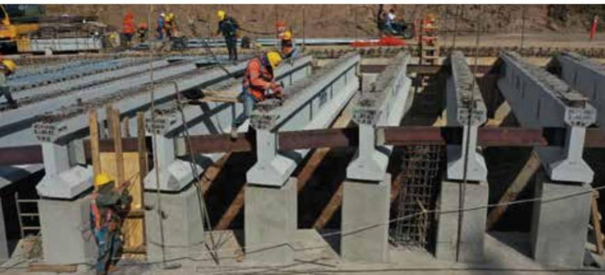
Construcción de puente de 115 m de longitud que consta de un distribuidor vial de 4 ejes, para el entronque Camino Real Acatitlán – Valle de Bravo. Incluye puente peatonal, obras de drenaje, pavimentación con concreto asfáltico, señalamiento, alumbrado y obras complementarias.
