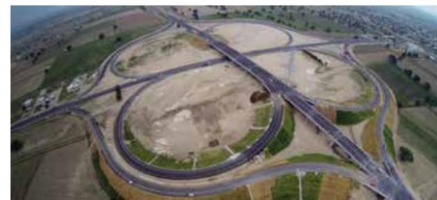
Esta obra contempla la construcción de vías de acceso, 2 pasos superiores vehiculares, 3 entronques y 1 puente sobre río, que suman una longitud total de 9 km, que incluyen: trabajos de terrecería, pavimento de concreto asfáltico, obras de drenaje, estructuras, tierra mecánicamente estabilizada, obras complementarias, señalamiento horizontal y vertical.
