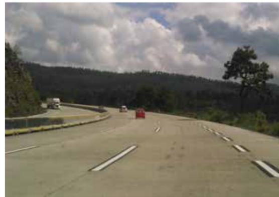
Rehabilitación estructural de la superficie de rodamiento con concreto hidráulico con una longitud de 10 km con 2 cuerpos de 3 carriles cada uno, incluyendo sus acotamientos, así como un segundo tramo de 11.2 km de longitud que incluye la nivelación con concreto asfáltico, trabajos de bacheo superficial, obras complementarias, señalamiento vertical y horizontal.
