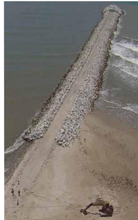
Tiene una longitud total de 220 m que incluye la reposición de cubos de concreto prefabricados con un peso de entre 50 y 280 kg para la capa de núcleo y secundaria, elementos ranurados de concreto entre 1 y 2.8 toneladas en la coraza, así como cubos de entre 0.5 y 7 toneladas para el morro provisional.
