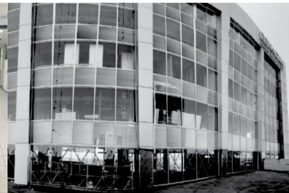
El proyecto contempla la Rehabilitación de 25,750 m<sup>2</sup> de planta en 14 niveles, acabados generales, instalaciones y sustitución parcial de la fachada de muro cortina del edificio. (1,800m<sup>2</sup>). Reconstrucción parcial de fachada de panel de aluminio tipo ALUCOBOND (820m<sup>2</sup>), Sustitución de fachada de celosía tipo C (360m<sup>2</sup>)
