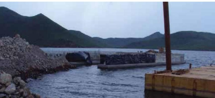
La estructura del Muelle se compone de una cimentación a base de pilotes (Columnas de Concreto) de 22" y 24" de diámetro, ejecutadas mediante encamisado de acero y que fueron cimentadas en forma entrecruzada. La superestructura se compone de losas de concreto que alcanzan 260ml.
